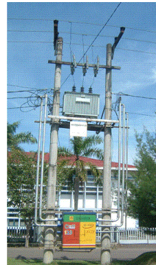
Gambar 2.6 Jaringan Distribusi Jenis Tiang (Sumber: Abrar Tanjung, 2012)
