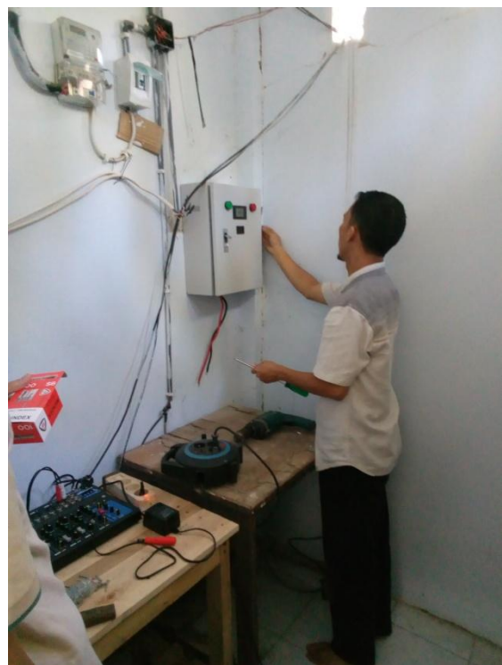
Gambar 5. Proses pemasangan box inverter
