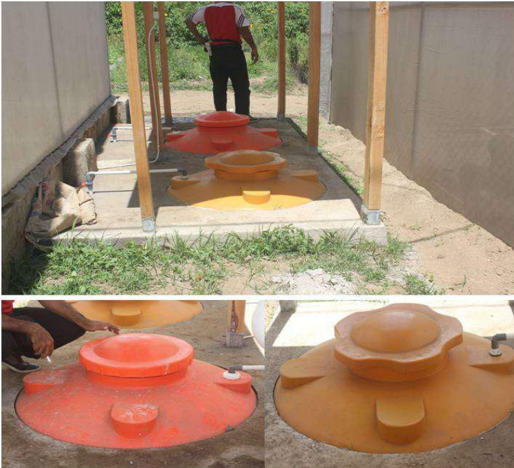
Gambar 10. Rumah Nutrisi dan Bak Nutrisi yang dibuat dan diletakkan diantara Screen House-1 dan Screen House-2
