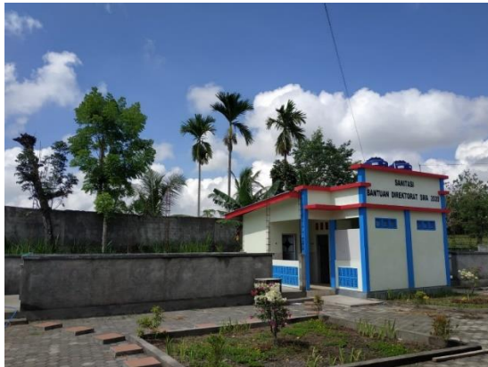
Toilet Sanitasi SMAN 1 Sakra
