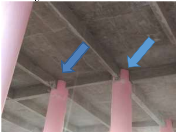
Gambar 12. Kerusakan struktural yang terlihat pada elemen balok pada bangunan TES Bangsal.
