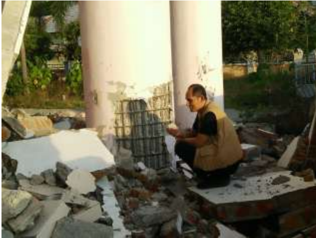
Analisa Kekuatan Kolom Beton Bertulang (Sebelum dan Sesudah dilakukan Metode Jacketing)
