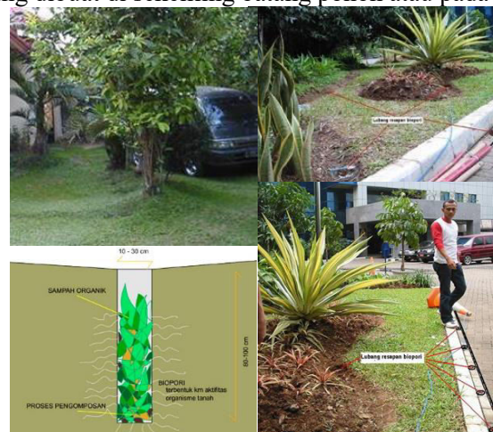
Gambar 1. Foto peraga tentang tata cara pembuatan lubang biopori.
