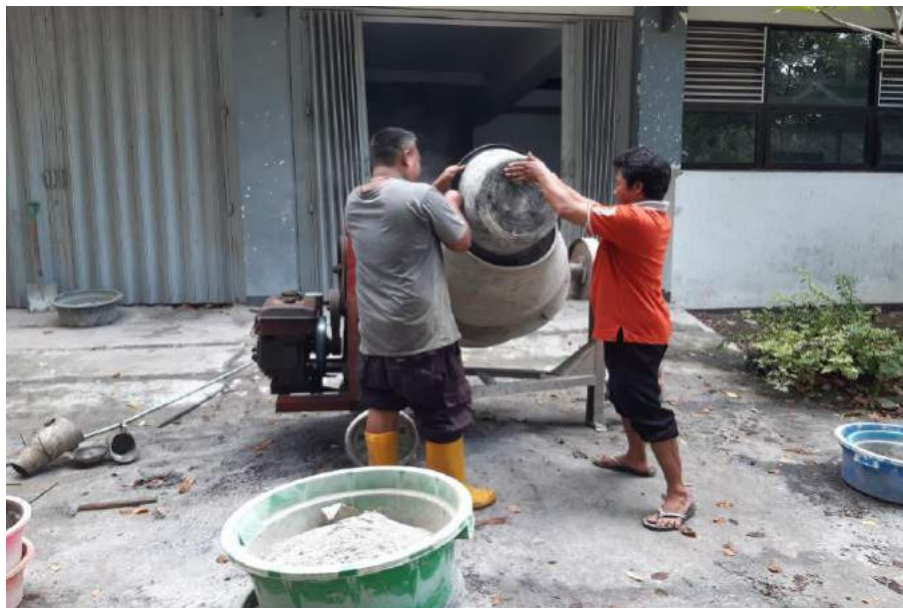
Gambar 3.2. Pengadukan bahan campuran beton dengan molen
