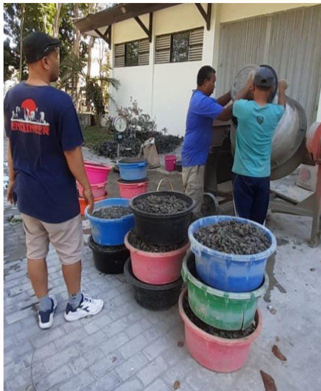
Gambar 3.7. Persiapan pencampuran beton dengan molen
