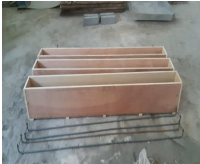
Gambar 3.4. Bekisting dan tulangan polos 10 mm
