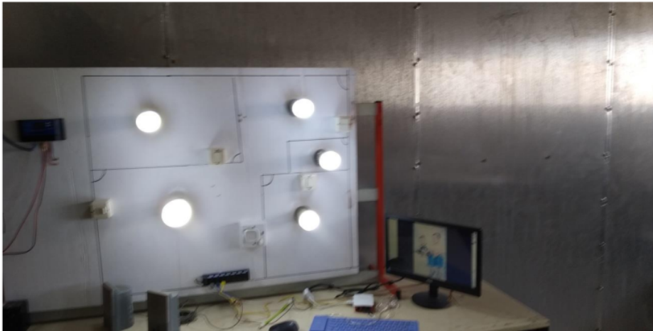
Gambar 1. Panel PLTS dengan sistem kelistrikan 12 Vdc
