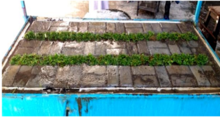
Gambar 5. Pemasangan Paving Block Pola Anyaman Tikar Dengan Penambahan Rumput Gajah Mini
