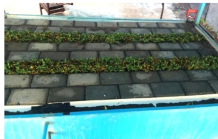
Gambar 4. Pemasangan Paving Block Pola Susun Bata dengan Penambahan Rumput Gajah Mini
