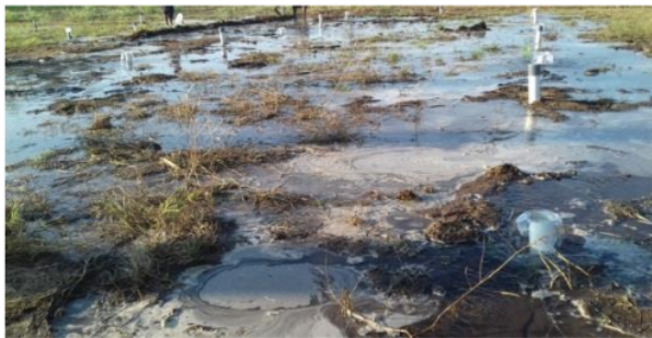
Gambar 1. Pengujian Irigasi Leb pipa
