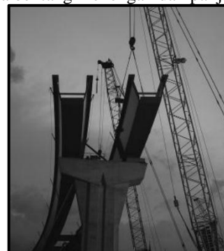
Gambar 1 Contoh Jembatan Box Girder Baja
