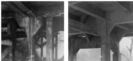
Gambar 1. Kolom dan Balok Viaduct sebelum dan sesudah perbaikan
