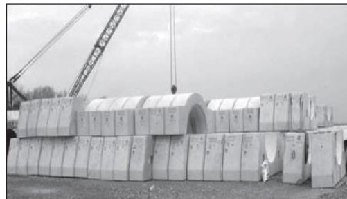
Grafik 2.1 Salah satu bentuk pemberat pipa HDPE bawah laut (Plastic Pipe)
