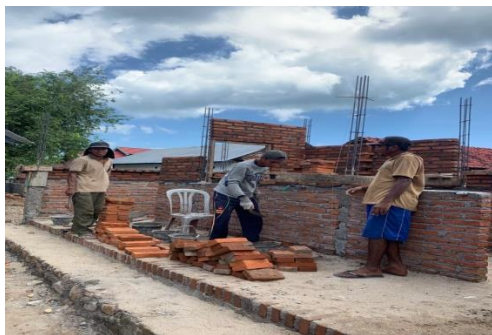
Gambar 3. Kegiatan pembangunan masjid
