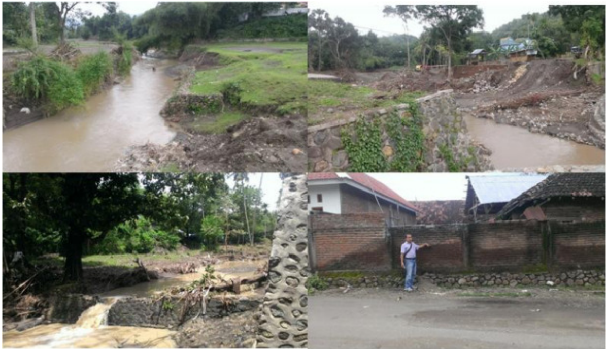
Gambar 7 Kondisi Dan Pengukuran Penampang Banjir
