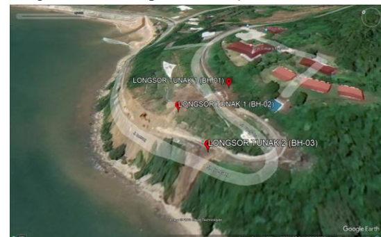
Gambar 1. 1 Kelongsoran lereng jalan akses TWA Gunung Tunak
