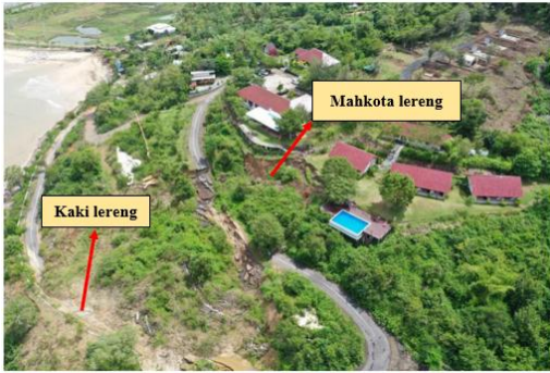
Gambar 4. 2 Kondisi longsor pada jalan akses TWA Gunung Tunak
