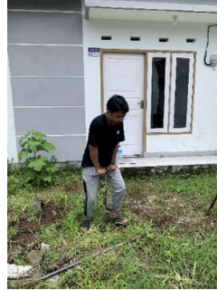
Pengeboran tanah untuk lubang resapan biopori
