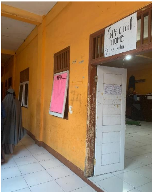
c. Ventilasi Udara
