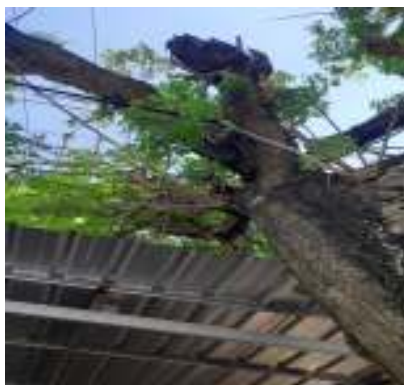
Gambar 11. Kerusakan cabang patah/mati di jalur hijau
