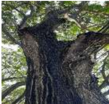
Gambar 5. Kerusakan resinosis di jalur hijau
