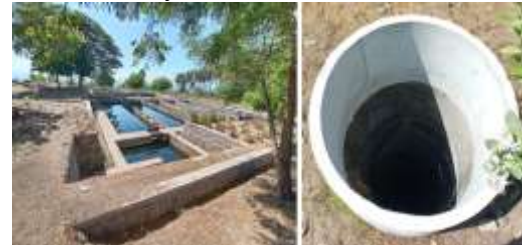
Gambar 4.3 Bangunan Pengolahan Lindi dan Sumur Pantau
