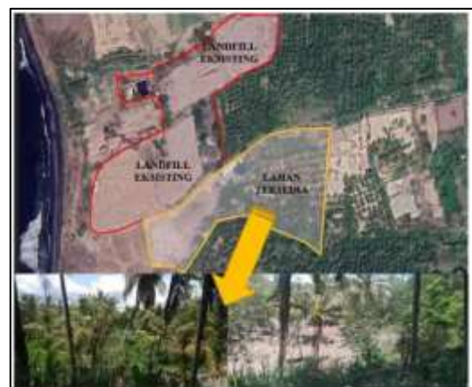
Gambar 3.2 Lokasi perluasan lahan TPA Ijobalit Kabupaten Lombok Timur
